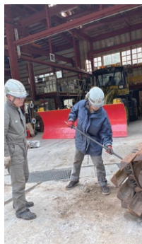
バックホー(ショベルカー)のシュー交換作業
